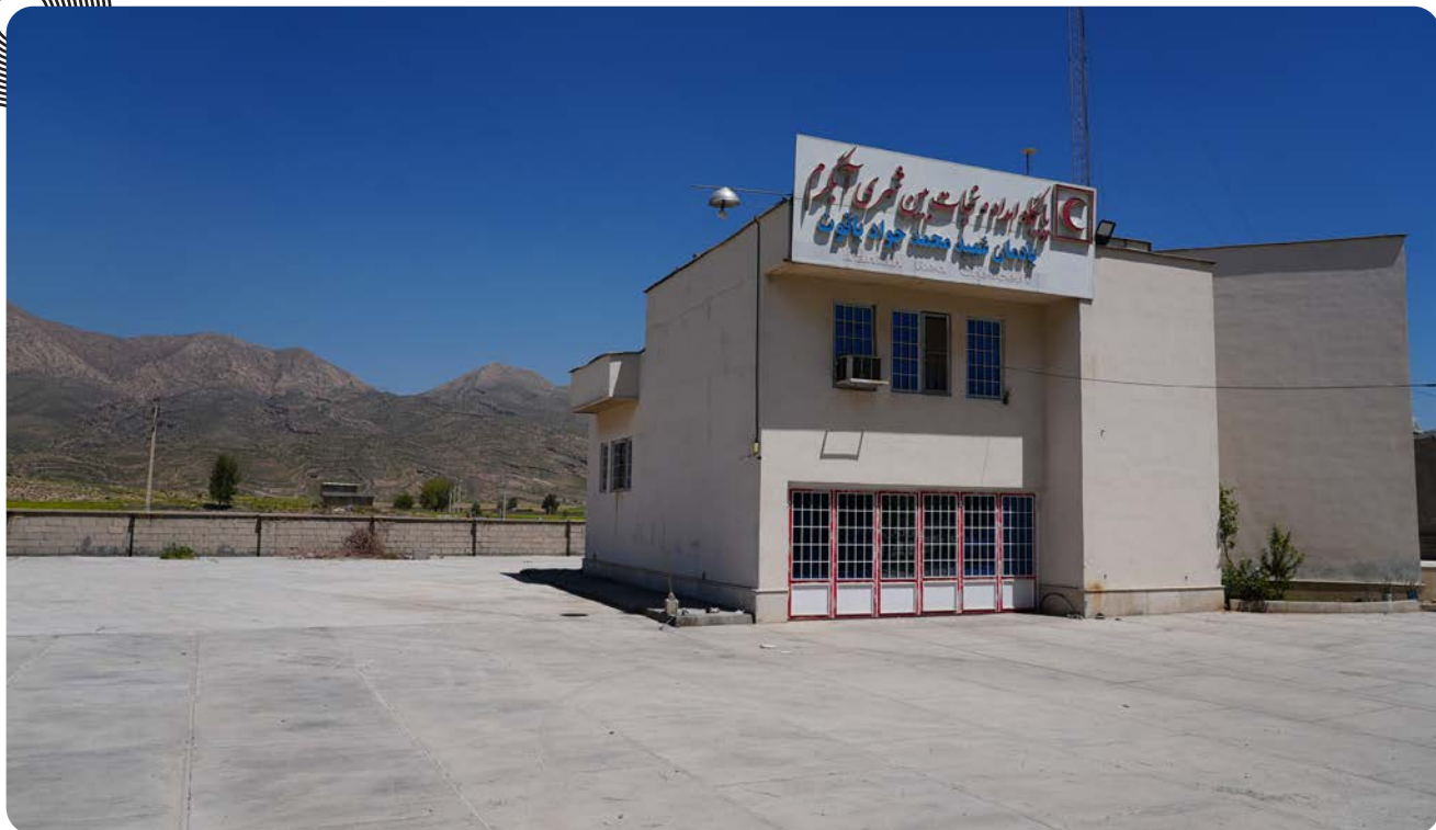
کف سازی بتنی پایگاه امداد بین شهری آب گرم
