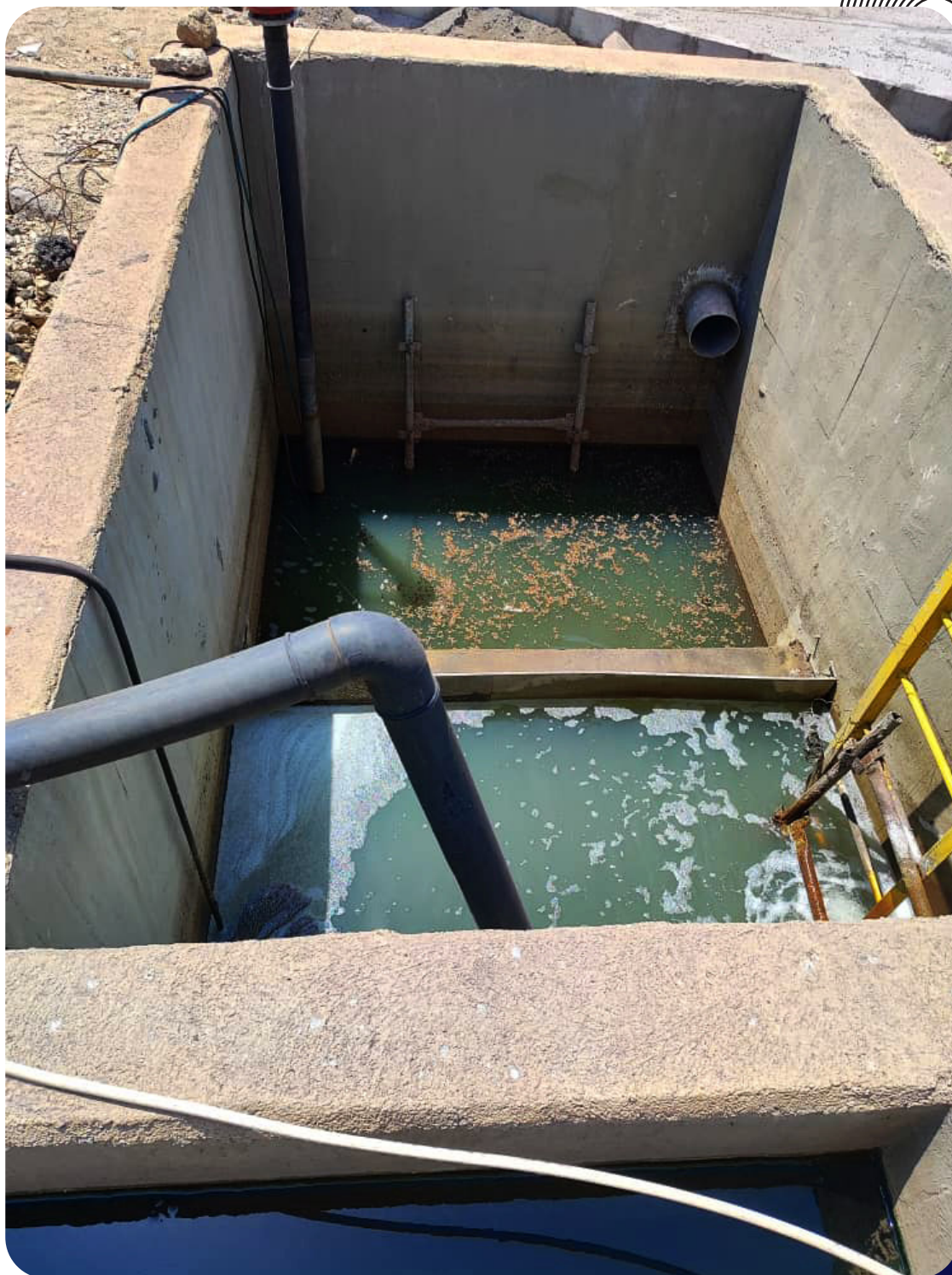
احداث تصفيه خانه فاضلاب بهداشتی
