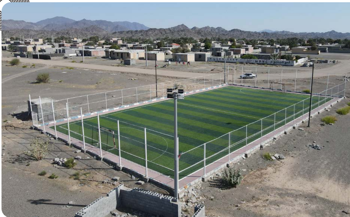
احداث زمین چمن ورزشی روستای زمین بند
