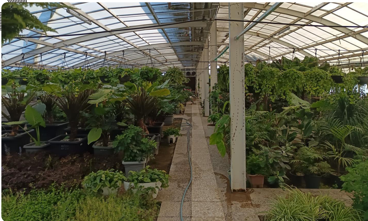
ساخت گلخانه فولاد پاسارگاد
